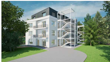
BLICK VON NORDOST
