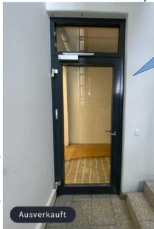
1-flügelige Brandschutztür Hörmann 1120x2750x85
